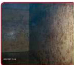
Développement de moisissures sous le revêtement
