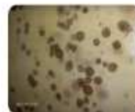
Développement de moisissures sous le revêtement
