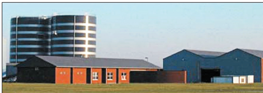
Figure 1. Usine de méthanisation de Mons (Belgique, photo IDEX)
